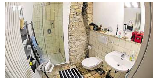
Alles hat seinen Platz, und das historische Mauerwerk gibt selbst dem Bad ein besonderes Flair.
